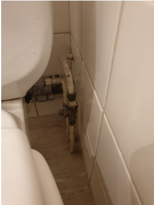
Tappvattenledningar ut ur golv i våtrum
